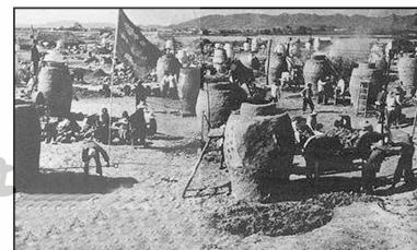
图一 小土炉炼钢铁
